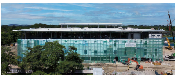
Bouwwerkzaamheden in Kuching, Maleisië
